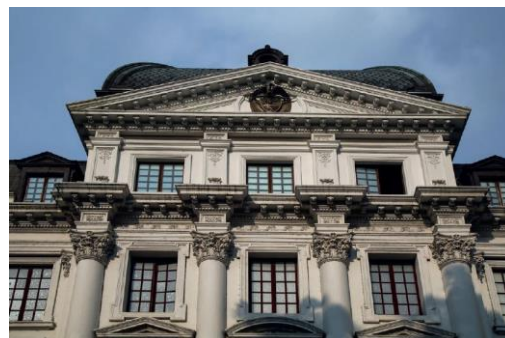
Restauración Palacio Municipal de Cali
