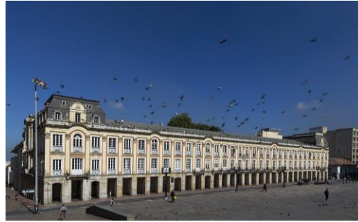
Mantenimiento de Fachadas del Palacio de Liévano en Bogotá
