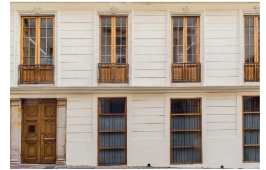
Intervención Casa de la Imprenta-Ministerio del Vivienda en Bogotá
