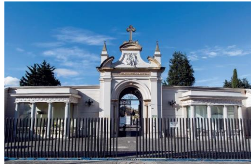
Intervención Portada del Cementerio Central en Bogotá.
