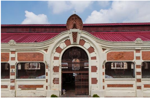
Intervención y restauración Plaza Distrital de mercado las Cruces en Bogotá
