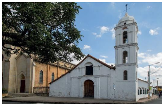
Intervención Iglesia Santiago Apóstol en Tenjo
