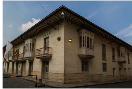
Intervención Casa la Giralda-Ministerio del Interior en Bogotá
